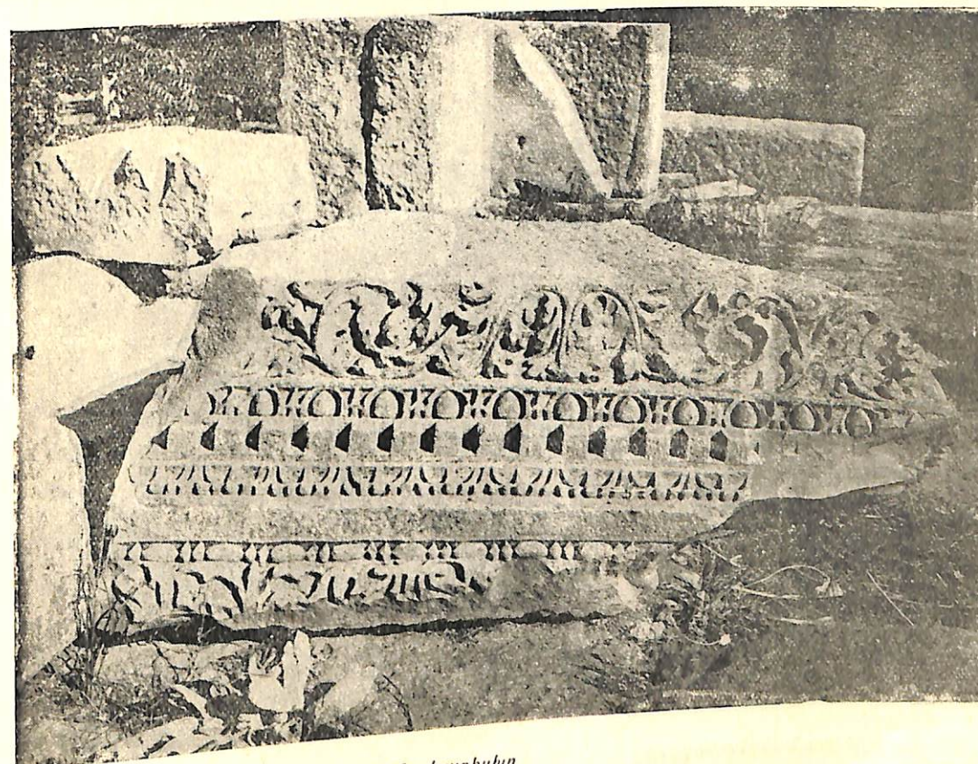
Նկ. 125. Մուտքի դռան ֆրիզավոր վերնասանդիկը Рис. 125. Сандрик с фризом входной двери Fig. 125. Linteau à frise de la porte d'entrée.
