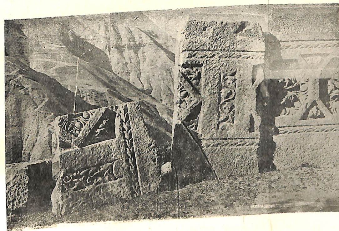
Նկ. 148. Արեւմտյան ծակատի պորտիկի վրածածկի սալը Рис. 148. Плита перекрытия портика западн. фасада Fig. 148. Dalle du portique de la façade ouest.
