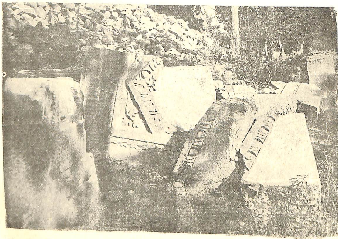
Նկ. 134. Հյուսիսային ծակատի պորտիկի վրածածկի սալը Рис. 134. Плита перекрытия портика северн. фасада Fig. 134. Dalle du portique de la façade nord.
