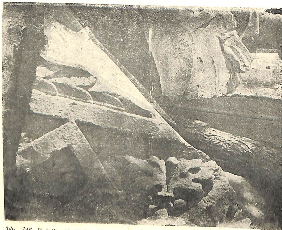
Նկ. 146. Արեւելյան ծակատի պորտիկի վրածածկի սալը Рис. 146. Плита перекрытия портика восточн. фасада Fig. 146. Dalle du portique de la façade est.
