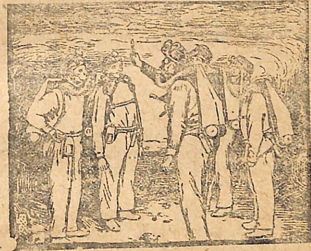
Ն 30. Փրկարար ջուկառ հանքերում. յուրաքանչյուրը մեջքին ունի թթվածնով լի գլան. գլանից թթվածինն անցնում և սեղինն պարկի մեջ, փոք գանվում և յախապահպանակ առ փի մեջ, իսկ այնտեղից ել՝ զեմքին հագած կրտսերի:
