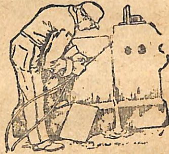
Նկ. 29. Մեռադը թթվածնա-ացեալինալին բուցի ոգնությամբ կտրելը:
