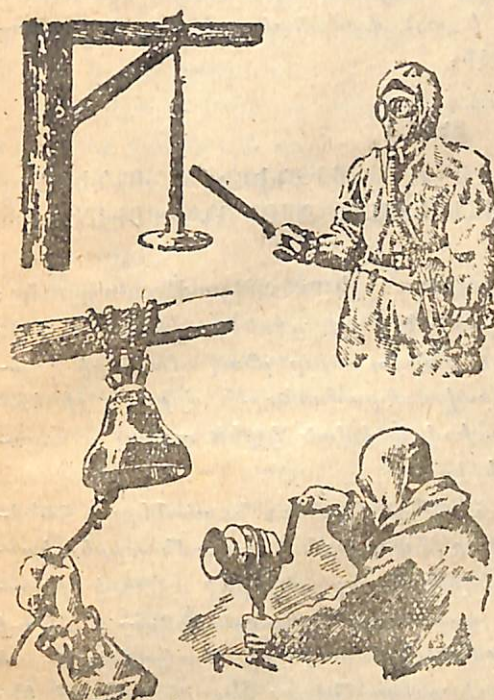
Նկ. 5. Քիմիական և հրդեհային տաղնապի աղդանչանները: Վերեւ՝ բուֆեր, ներքեւ՝ զանգ (ձախից) և սիրենա (աջից):
