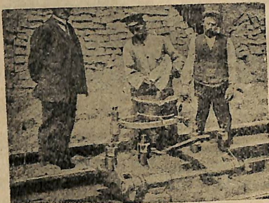
Նկ. 17 Գ. Տեղադրութիւն եւ սիւնիլը յեզ մեջը լցնում եւ սերմիտ խառնուրդը
