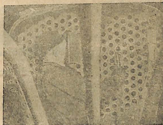
Նկ. 75. վարպետը կրակարանում ելեկտրոյեռի միջոցով ուժեղացնում է խողովակների պնդությունը.
