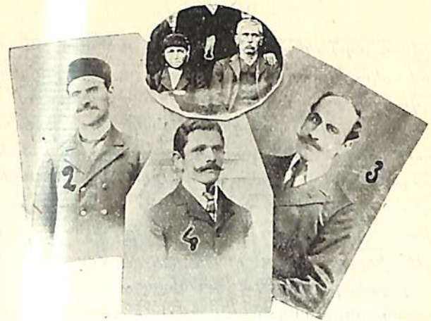
Սայ-Կէշիսի ջարդին մէջ նահատակուած Հանրեցիներէն ոմանք Տէր եւ Տիկին Միւայէլ Ալբեան , Պաս. Մէլիսնց Մալեան , Պաս. Կոստանցի Ք. Սիյանեանք եւ Պաս. Արսաւէս Պոյանեան .
