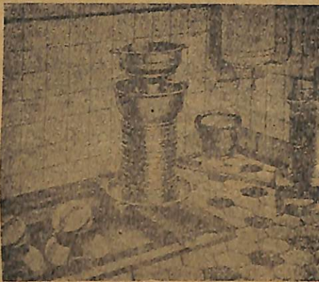
Նկ. № 8. Կաթի պաղարակը տեղափոխվում է պաղարակից ավազանի վերևում : Դրանով վերանում է պաղարակը շատ բարձր տեղ դնելու անհրաժեշ- տությունը, վորով նշանակում է կաթի պաղարակի մեջ լցնելը :
